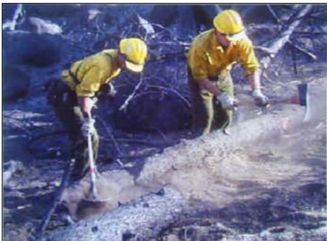
Photo 7 : Installation de barrage de troncs de pins pour la rétention des sédiments dans une zone incendiée. Il s'agit d'un moyen classique de réhabilitation post-incendie dans de nombreux pays. La photo provient des Services Forestiers des U.S.A.
